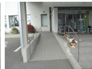
出入口の段差解消 事業費：30万円程度
