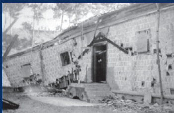
▼爆発で崩れた禁野火薬庫倉庫
