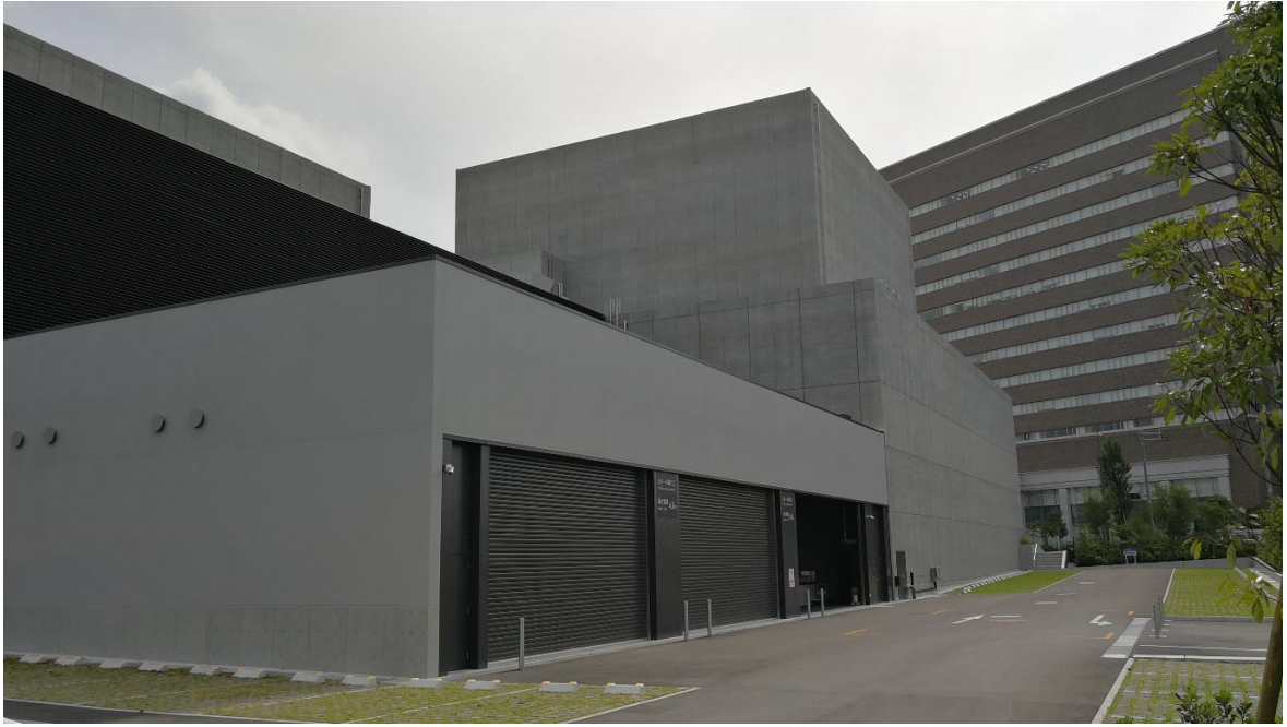
建物外観（北側）
