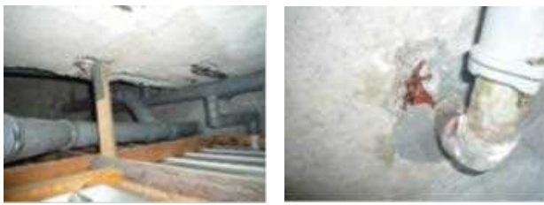
例：改修が困難なスラブ下配管において、配管が腐食し漏水等が生じているマンション
