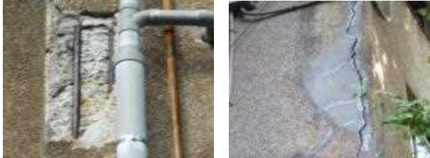
例：外壁のひび割れ、鉄筋腐食等が広範囲に生じ、外壁等の落下のおそれがあるマンション
