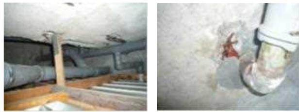
例：改修が困難なスラブ下配管において、配管が腐食し漏水等が生じているマンション
