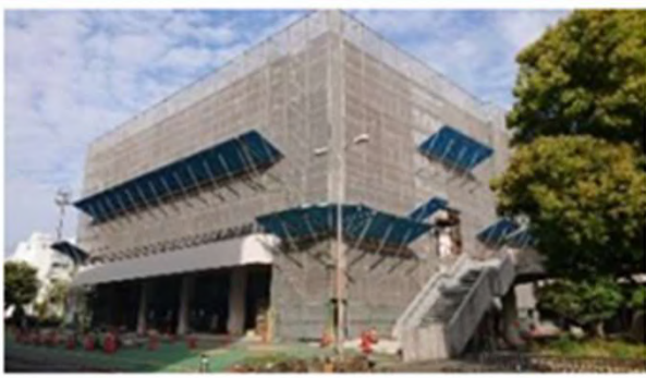
工事中の大ホール棟 (2021年4月6日撮影)
