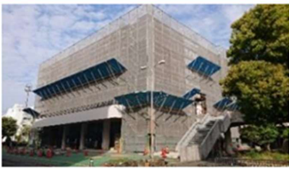
工事中の大ホール棟 (2021年4月6日撮影)
