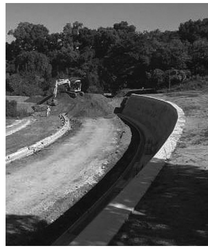
整備工事中の御殿山小倉線(写真は甲斐田川付近)
