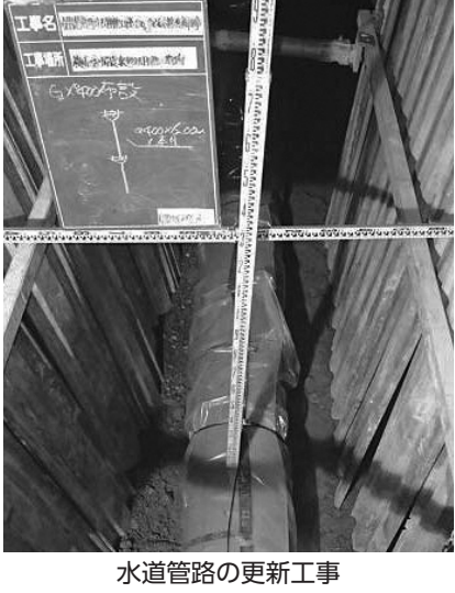
水道管路の更新工事
