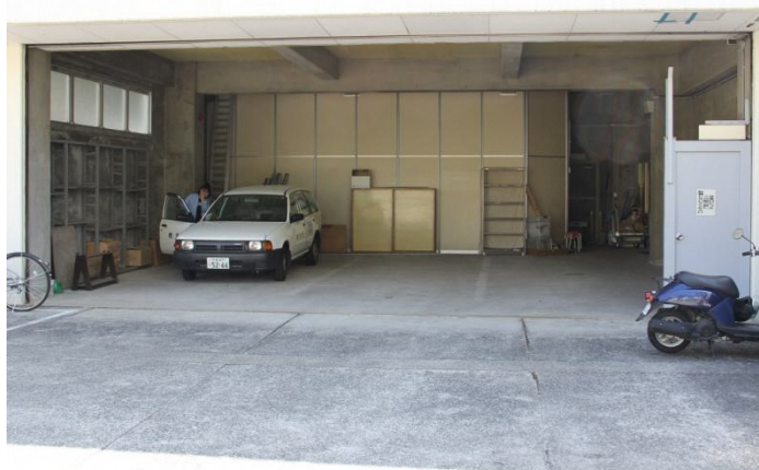
現在は使われなくなった旧自動車文庫基地が現存しており、敷地が有効に活用されていない
