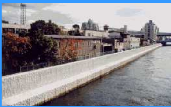
南海トラフ巨大地震対策 (堤防の耐震化)
