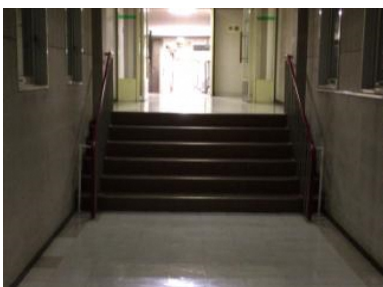
障壁となっている渡り廊下
