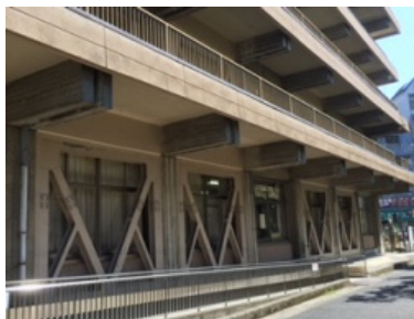
防災拠点としての耐震性の不足
