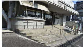
枚方消防署入口 階段となっており、スロープも設置されていない。
