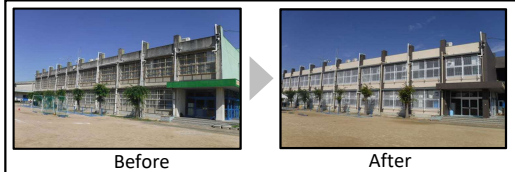
【改修事例：外壁改修】
