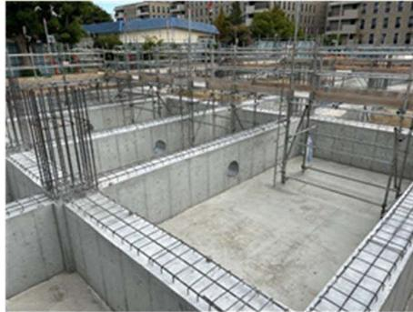
3 工区 基礎配筋施工中
