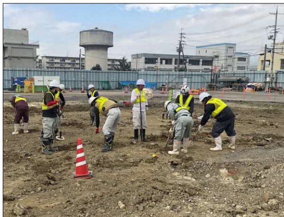
■金属探査と手作業による掘削
