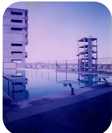
※ 完成当初の東署訓練塔及びプール
