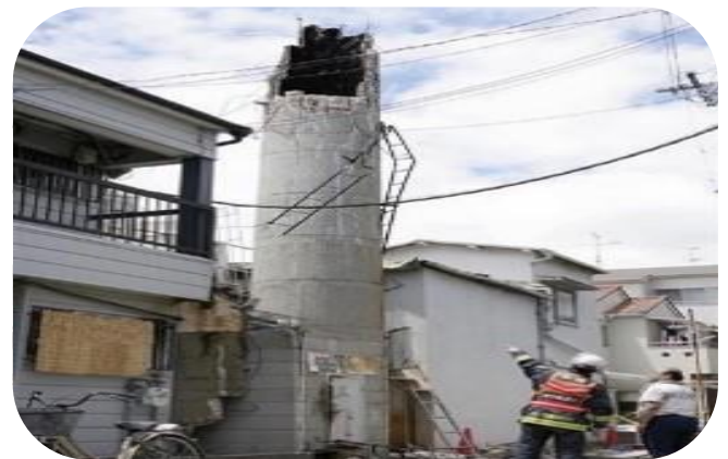
※ 大阪府北部地震の被害状況（枚方市南中振 2 丁目）
